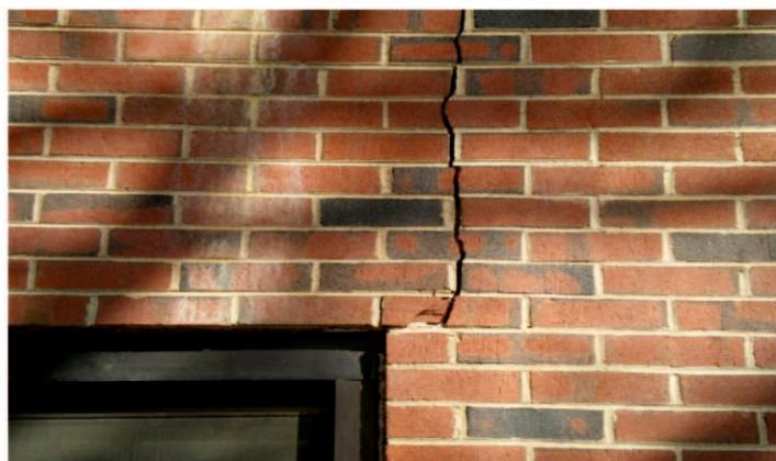
Трещина в неармированной стене
