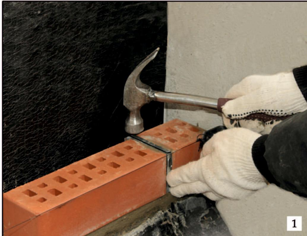
В первом ряду устанавливаются малые вентиляционные короба в вертикальный шов облицовочной кладки с частотой в 2-3 кирпича. Такой же монтаж малых вентиляционных коробов производится и в последнем ряду кладки для обеспечения качественного притока воздуха. Это необходимо для правильного микроклимата при сезонных колебаниях температуры в многослойных стеновых конструкциях.
