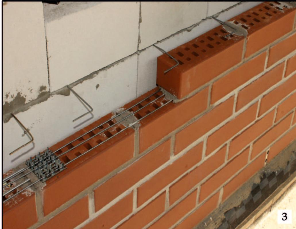
На фотографии используется фасадный клинкерный кирпич "RAUF" красный, коллекции «Лондон», с гладкой поверхностью. Кладка лицевого клинкера осуществляется на специальную цветную клинкерную смесь с водопоглощением от 2% до 5% производства ЛСР. Кирпичная кладка усиливается арматурным прутком, который защелкивается в фиксатор «ЁЖ». Необходимое количество рассчитывается согласно проценту армирования.
